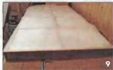
Уложенный в клетки каркаса пенополистирол изолирован с обеих сторон специальным полотном
