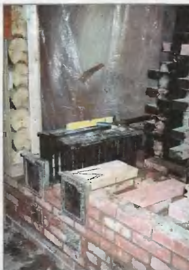
Во время ремонта установили дополнительную прочистную дверку
