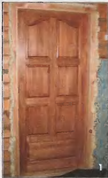
Коробчатая утепленная дверь с филенчатым фасадом и смотрится великолепно, и тепло бережет
