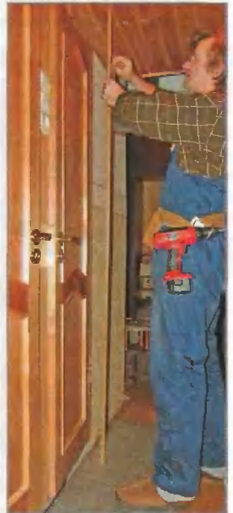
От качества монтажа наличников зависит внешний вид дверей санкабины
