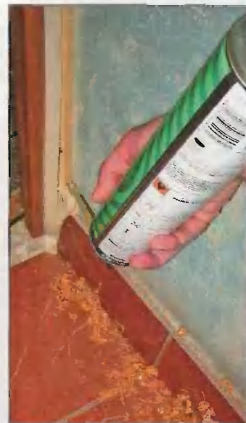
Щели между косяками и стенами заполнил монтажной пеной
