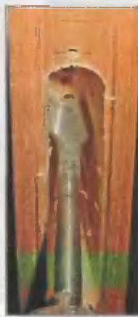
Гнездо под замок также удобно делать перовым сверлом
