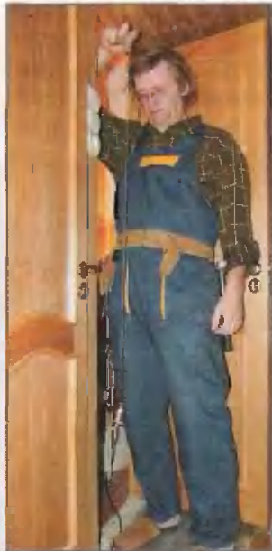
Проверить точность установки дверной коробки можно с помощью отвеса
