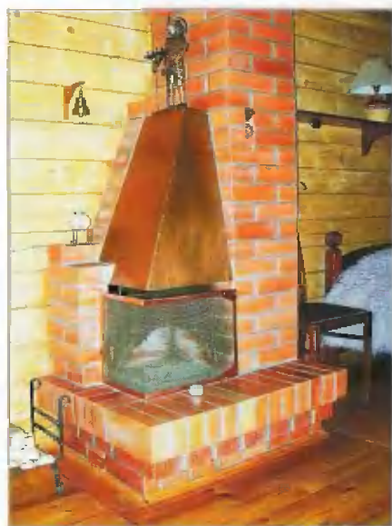
Стандартные решетки для камина на втором этаже не подошли и из латунной сетки и медных полос мы изготовили угловую решетку
