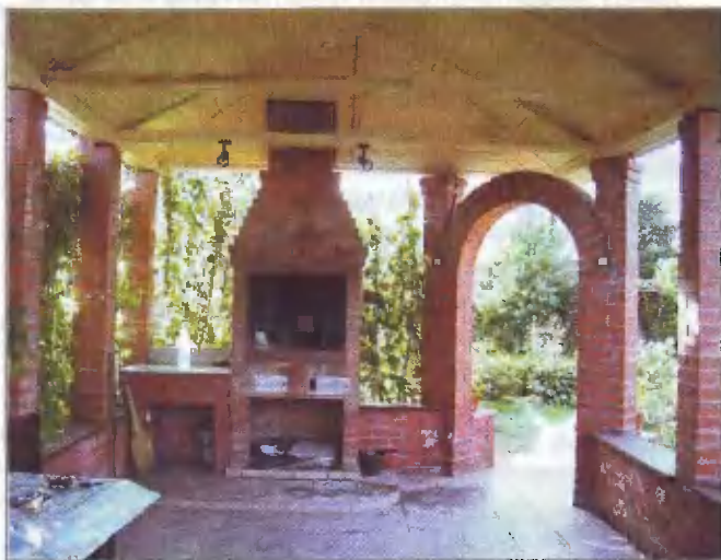
Пол в беседке выложен плиткой с небольшим уклоном. Мангал и разделочный стол стоят на возвышении высотой 100 мм
