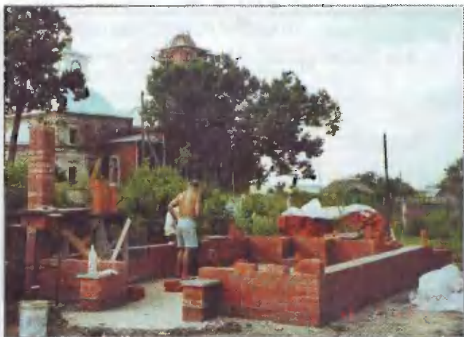
Рабочий момент стройки. На уже готовый цоколь поставлена первая колонна
