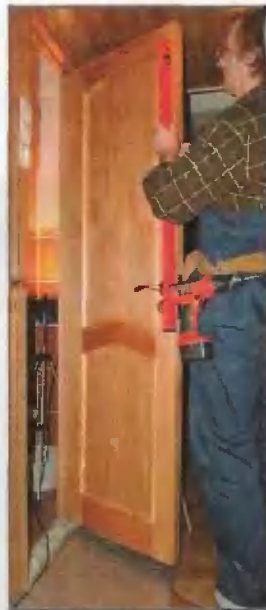
Правильность установки двери я проверял строительным уровнем при разных положениях ее полотна
