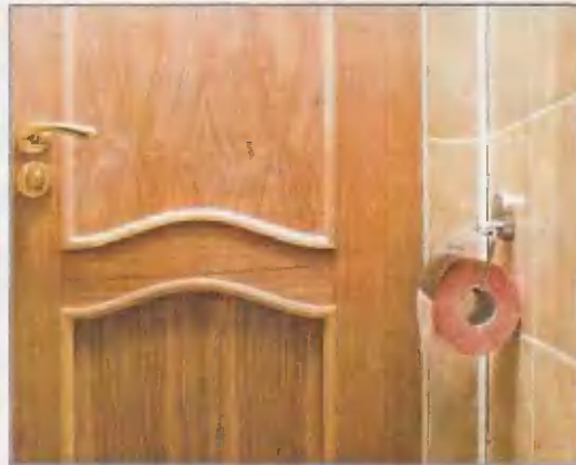
Внутри помещений наличники не устанавливал. Примыкание оформил пластиковой раскладкой и кафельной плиткой
