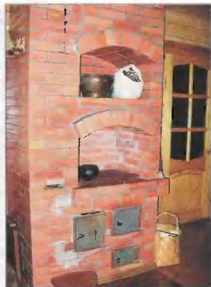
Кухонная печь после кладки практически не требовала дополнительной отделки
