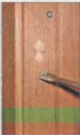
Чтобы сделать гнезда под язычки защелки и замка, я использовал перовое (центровое) сверло
