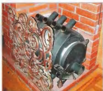
В спальне на втором этаже установили печь «Буллерьян»
