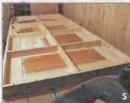
Филенчатая конструкция усилена реечным каркасом
