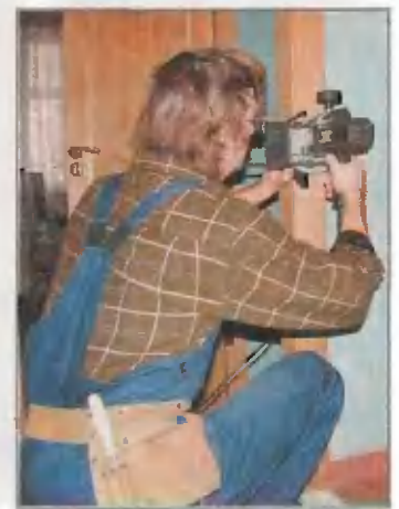
Выборку под штребню (как и под петли) выбирал ручным фрезером
