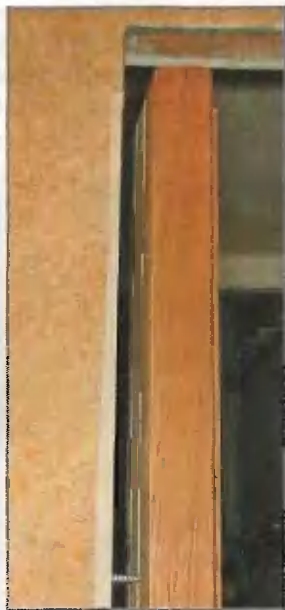
К стене санкабины, изготовленной из двух листов плоского шифера с деревянными брусками между ними, косяки я крепил шурупами
