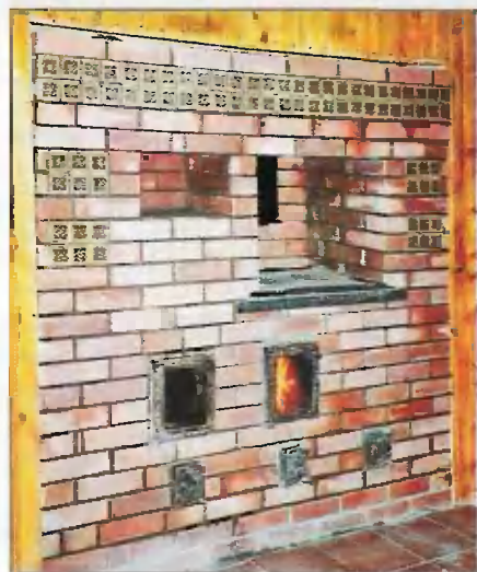
Первая топка печи после ремонта
