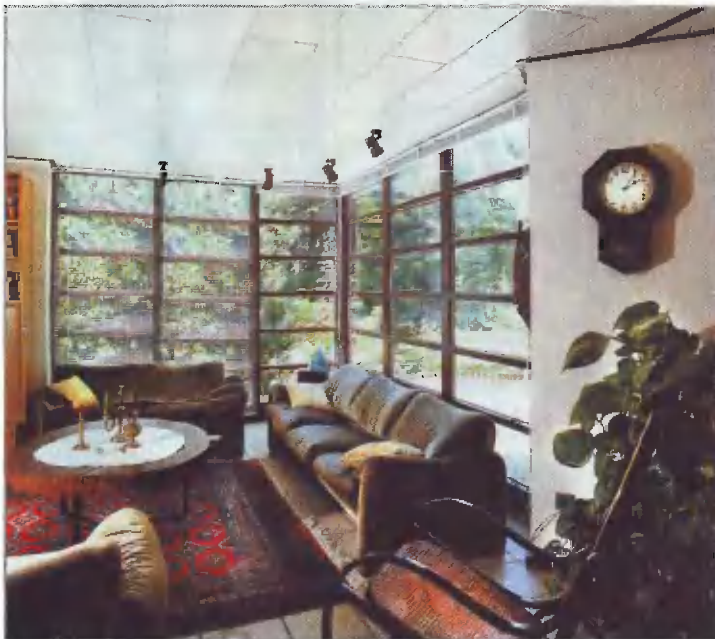
Большая площадь остекления обеспечивает естественное освещение гостиной. Рамы окон, расположенных под прямым углом друг к другу, изготовлены из древесины твердых пород. Пол во всех трех помещениях покрыт светлой плиткой, что дополнительно подчеркивает их единство
