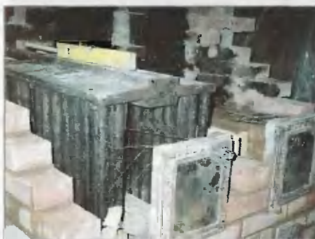
Котел представляет собой вертикальные пучки соединенных параллельно трубок Ø25 мм, по которым циркулирует теплоноситель
