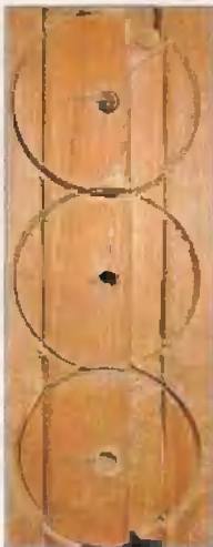
Отрезок бруска между косяками нужен только для задания нужного направления кольцевой пиле. После того, как отверстия в косяках будут просверлены на необходимую глубину, брусок следует удалить
