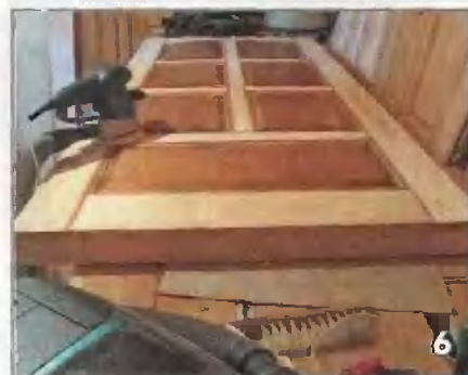
Шлифовку обвязки филенчатой конструкции целесообразно делать после скрепления лицевой части двери с реечным каркасом
