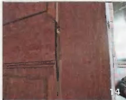
Если не предусмотреть конструктивных зазоров в сочленениях филенок с обвязкой, конструкцию может разорвать
