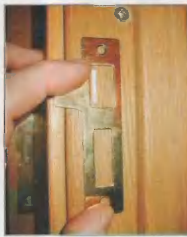
Белая краска, нанесенная на язычок защелки замка, позволит точно определить местоположения штребни
